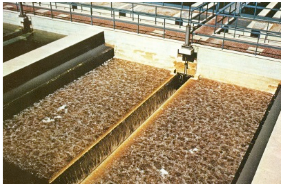
Filtro a sabbia in controlavaggio
